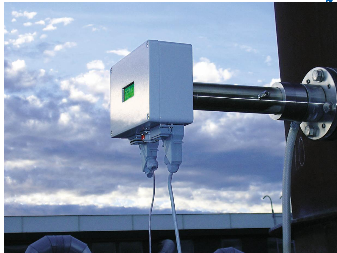
Analizator LaserGas ® SP II zamontowany na kominie
