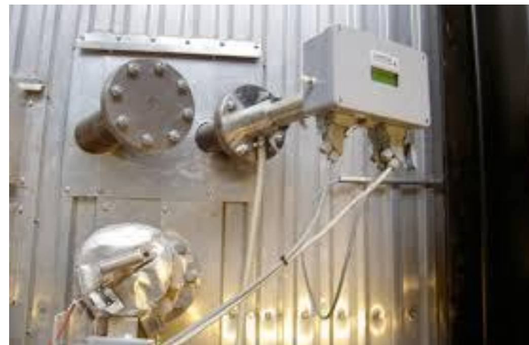
Analizator LaserGas® II SP zamontowany na kominie
