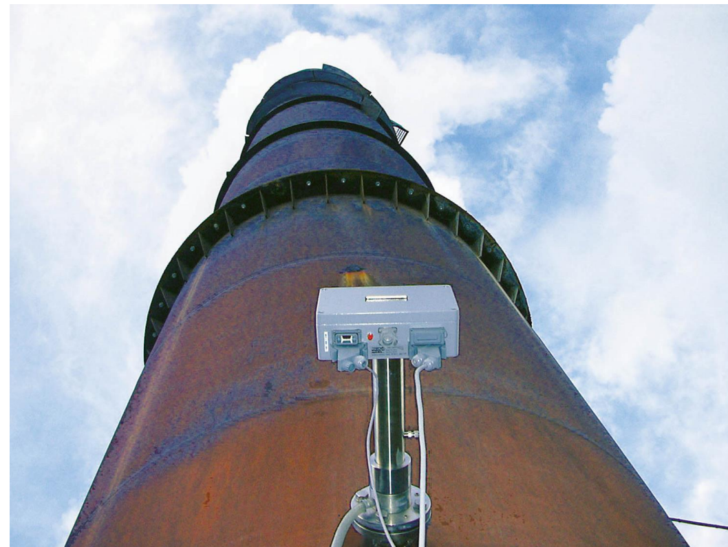
Analizator LaserGas® II SP zamontowany na kominie.
