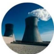
Elektrownie i elektrociepłownie
