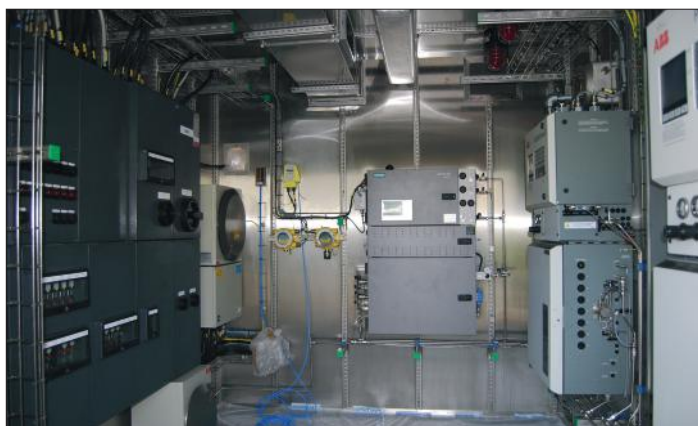
Kontenery z zestawem pomiarów fizykochemicznych dla przemysłu petrochemicznego.
