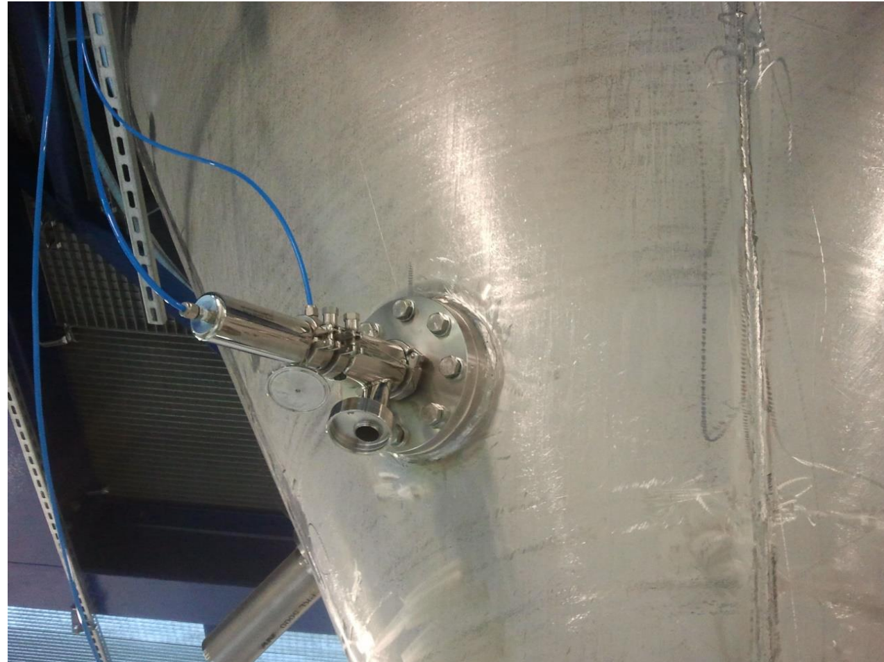
Isolok SAK – pobór nawozów sztucznych z silosa
