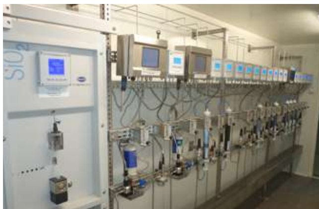
Wnętrze kontenera do pomiarów fizykochemicznych
