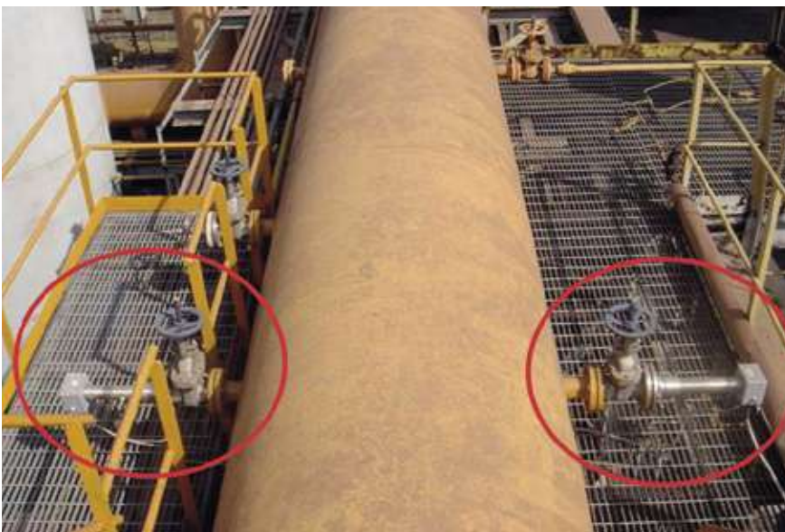
Wiązka laserowa prześwieca całą średnicę kanału. Na zdjęciu widoczne dodatkowe zawory odcinające.
