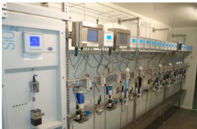
Wnętrze kontenera do pomiarów fizykochemicznych
