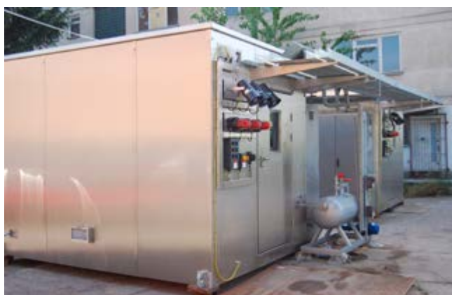
Kontenery z zestawem pomiarów fizykochemicznych wykonane do pracy w strefie zagrożonej wybuchem
