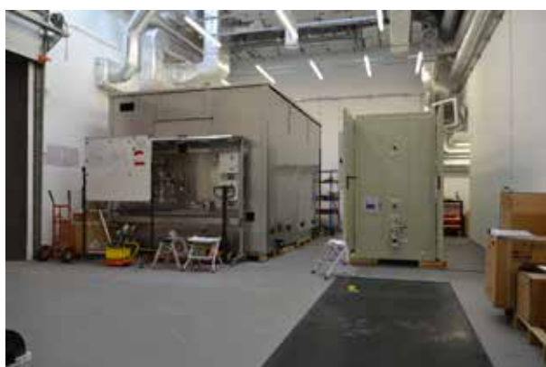
Hala produkcyjna firmy Technopomiar Sp. z o.o
